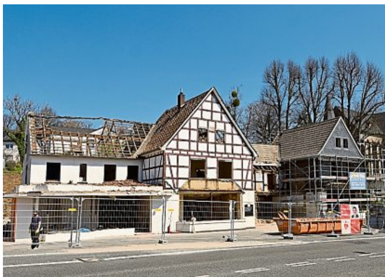
Die Gaststätte Oessenich beim Abbruch im Frühjahr 2021.
